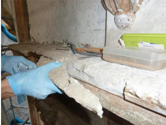
Proceso de fijación de la moldura con tubillón y adhesivo epoxi
