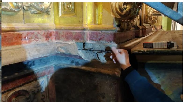
Colocación de las varillas de fibra de vidrio como soporte
